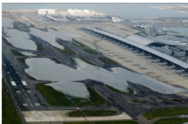
Aéroport du Kansai inondé après le passage du typhon Jebi (Source : ladepeche.fr)
