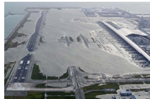
Aéroport d'Osaka inondé suite au passage du typhon Jebi – Septembre 2018
