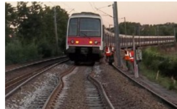
Exemple de déformation du rail suite à une vague de chaleur, SNCF
